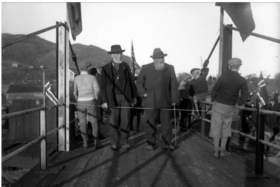
(Info: Bildet over her viser opninga av brua over straumen på Sandsøya i 1939. Vi ser dei to eldste på øya då, som fekk oppgåva med å klippe snora. Askjell Skare til venstre og Petter Skorpen til høgre på bildet. Det var ei skyvebru over nørdeste bruløpet. Dette var sjølvstakt for at større båtar skulle kunne bruke Vågen til hamn. Ishavsskuta Grande hadde oppankringsplass på Vågen. Rundt midt på -60 talet vart nye bruer etablert.)
